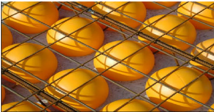
Şekil 6. BubbleDeck firmasının yeni nesil döşeme sistemi [14].
