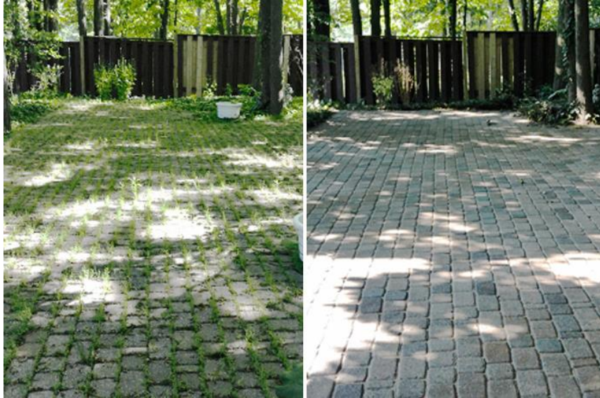
Şekil 1. Parke kaplama - kum temizlemesi [4]
