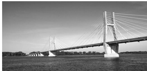
Şekil 3. Quincy Bayview Köprüsü
